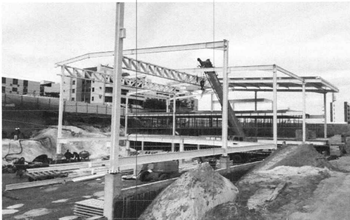
Estrutura metálica gera menos resíduos na obra
